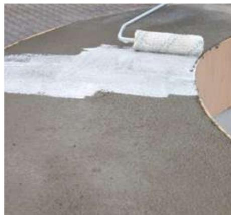
Aplicação com rolo MC-DUR 1177 WV-A no revestimento fresco-úmido
